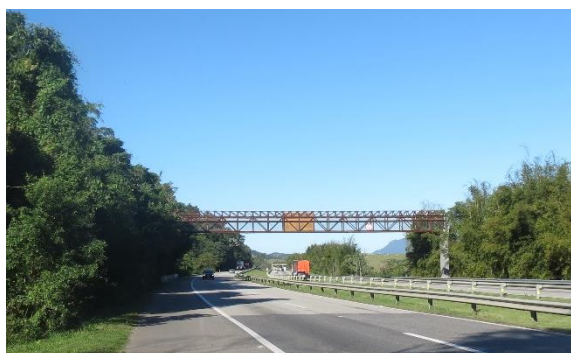
Figura 30. Passagem superior de fauna na BR-101/RJ. Foto: Helio Secco.
