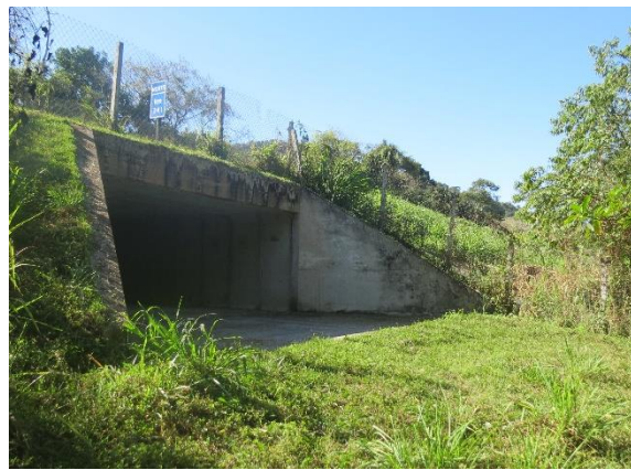
Figura 21. Passagem de fauna seca de concreto associada a cercamento na BR-101/RJ. Foto: Helio Secco. Neste caso, recomenda-se que a cerca seja implantada sobre a ala de concreto da embocadura, para que não exista vão entre a cerca e a estrutura de passagem.
