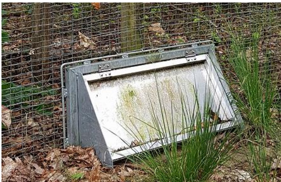
Figura 11. Cerca com estrutura de escape para animais: o dispositivo permite que o animal fuja para apenas um lado da cerca e impede que ele volte. Foto: editada de Simone Freitas, obra original sob licença CC BY-AS 4.0 ( https://creativecommons.org/licenses/by-sa/4.0/deed.en ), via Wikimedia Commons.
