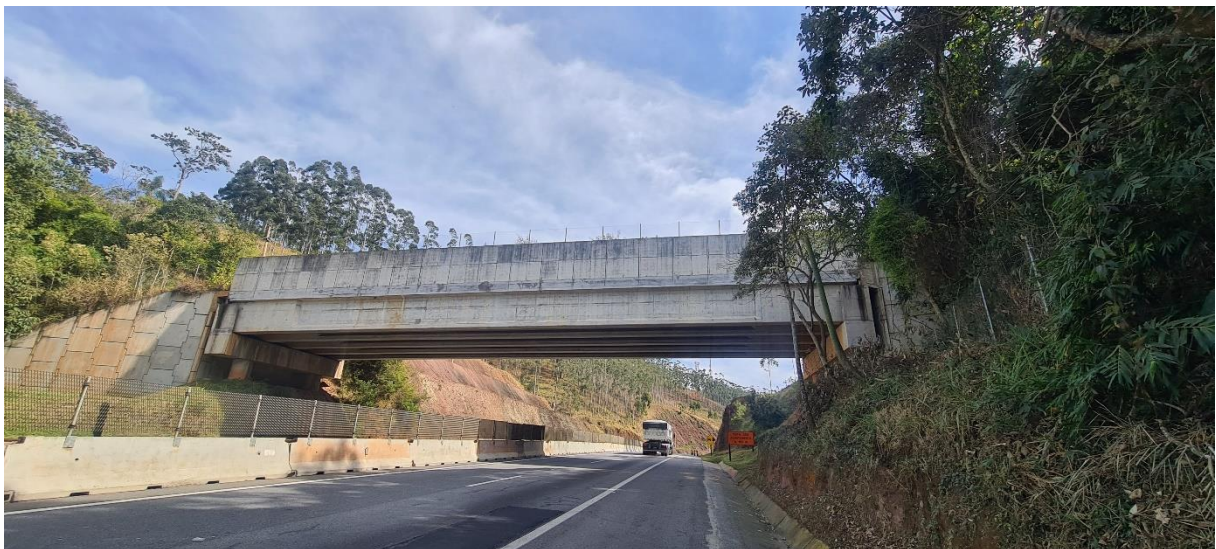
Figura 36. Viaduto para a fauna sobre a Rodovia dos Tamoios/SP-99. Foto: Erica Naomi Saito.
