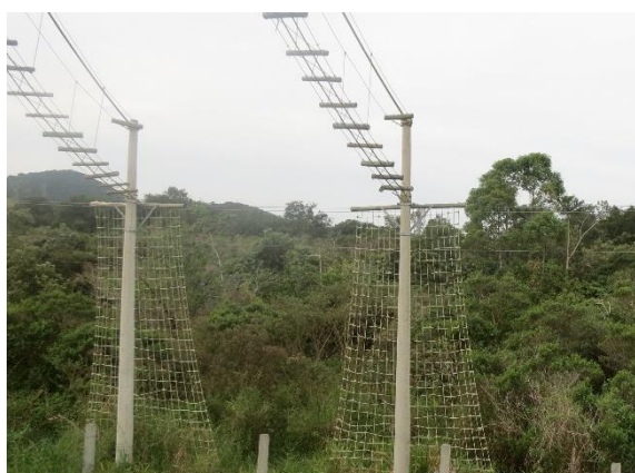
Figura 32. Detalhe das estruturas que ligam a passagem superior de fauna às árvores da vegetação do entorno na BR-101/RJ. Foto: Helio Secco.
