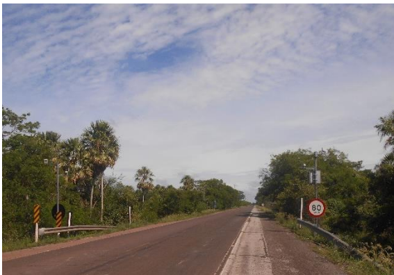
Figura 38. Radar eletrônico na rodovia BR-262. Foto: Miriã Ribeiro Costa.
