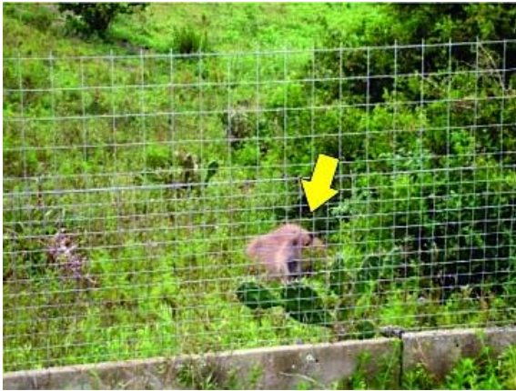
Figura 5. Capivara (indicada pela seta) bloqueada por cerca com malhas decrescentes em base de alvenaria na BR 471/RS. Foto: Mozart Lauxen.
