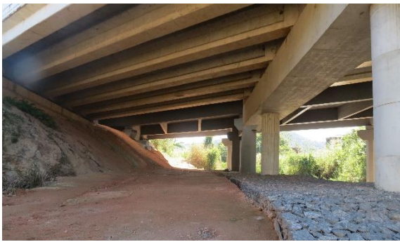
Figura 18. Vão de ponte com as laterais secas junto às cabeceiras para passagem de fauna na BR-101/RJ. Foto: Helio Secco.
