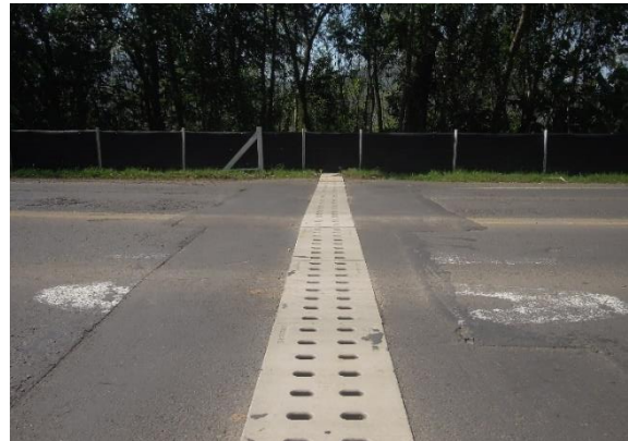
Figura 27. Parte superior do túnel climático em concreto polímero para anfíbios. Note cercamento ao fundo da imagem, na Rota do Sol/RS. Foto: Caroline Zank.
