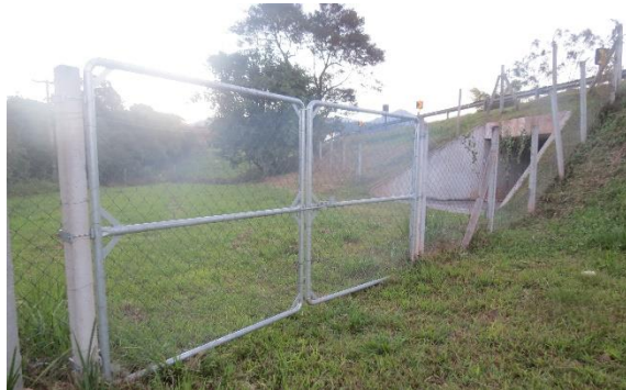
Figura 8. Portão de acesso instalado em cercamento associado à passagem de fauna na BR-101/RJ. Foto: Helio Secco.
