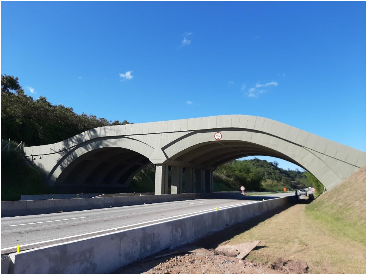
Figura 34. Viaduto vegetado sobre a BR-101/RJ. Foto: Helio Secco.
