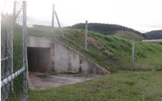
Figura 7. Cercamento associado à passagem de fauna na BR-101/RJ. Foto: Helio Secco. Neste caso, recomenda-se que a cerca seja implantada sobre a ala de concreto da embocadura, para que não exista vão entre a cerca e a estrutura de passagem.
