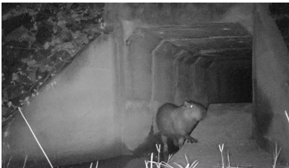
Figura 14. Exemplo de galeria de 1,5 m x 1,5 m com plataforma seca: capivara (animal semiaquático) utilizando a parte úmida. Foto: Robson Siqueira.
