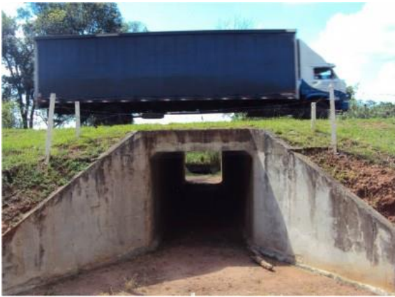
Figura 20. Passagem de fauna seca celular associada a cercamento. Foto: Fernanda Abra. Neste caso, recomenda-se que a cerca seja implantada sobre a ala de concreto da embocadura, para que não exista vão entre a cerca e a estrutura de passagem.
