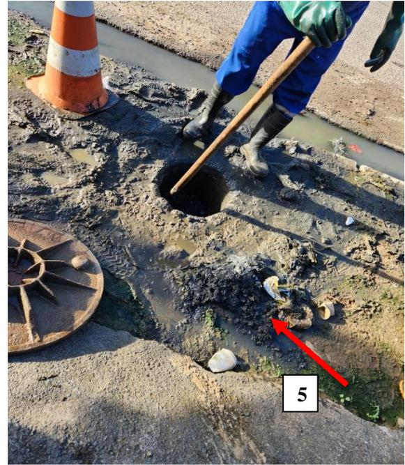
Fotos 03 e 04: Detalhe 4 – CI do ramal de esgoto obstruída pela contribuição de terra e lixo transportado pelo efluente que vem escoando de um ponto quebrado da drenagem da Av. Governador Roberto Santos. Detalhe 5 – Material retirado da CI, efetuando a desobstrução.
