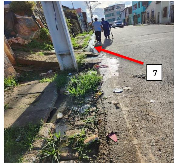
Fotos 05 e 06: Detalhe 6 – Extravasamento oriundo de dano/obstrução da caixa de drenagem, localizada em frente a escadaria de acesso da Rua 3, Bairro Alto da Esperança. Detalhe 7 – Efluente que vem escoando ao longa da Rua Governador Roberto Santos e acumulando na esquina com a Av. Ubaitaba.
