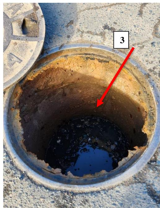
Fotos 01 e 02: Detalhe 1 – Local onde existe uma “boca de lobo” que está recebendo contribuições de pontos de drenagem danificados/obstruídos na Rua Gov. Roberto Santos e Av. Ubaitaba. Detalhe 2 – PV existente da rede coletora de esgoto. Detalhe 3 – PV de esgoto operando sem anormalidade.
